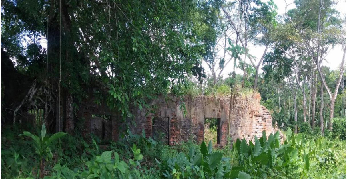
Figura 2 – Ruínas do Casarão Antigo denominado de APROAGA pelos quilombolas de São Domingos do Capim.
