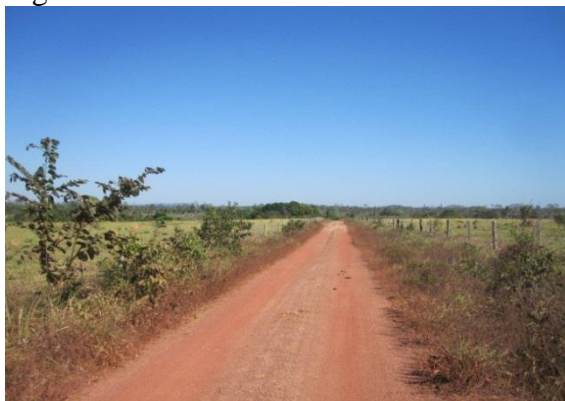
Figura 04: Estrada de acesso ao assentamento.
