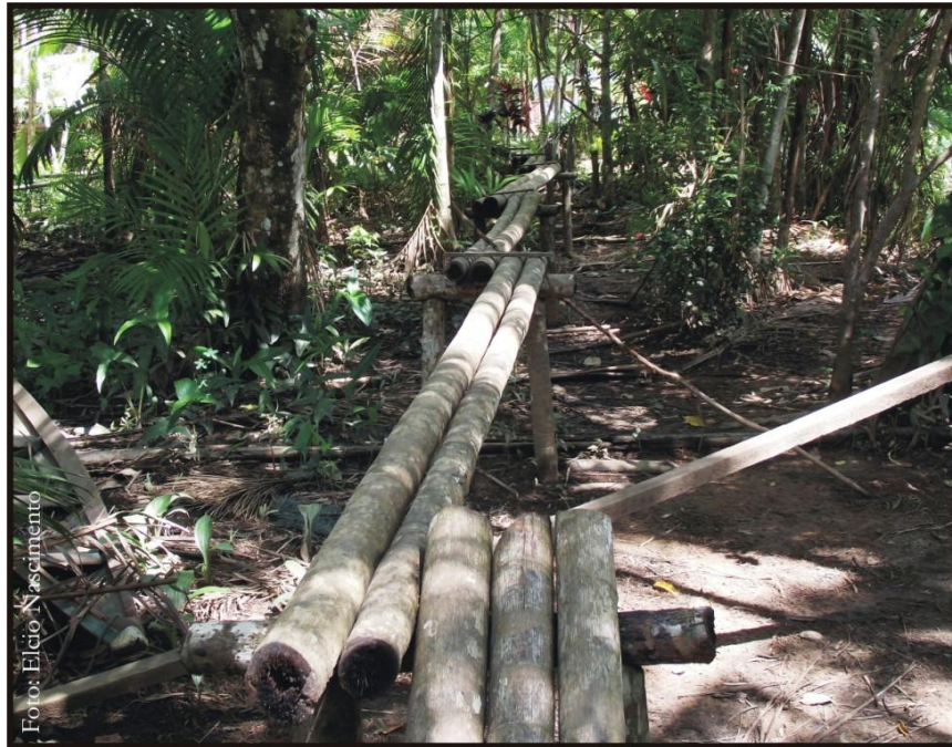
Foto 11 – Pontes construídas com o caule do açaizeiro, utilizados pelos moradores da comunidade quilombola do Baixo Acaraqui, Abaetetuba, Pará.
