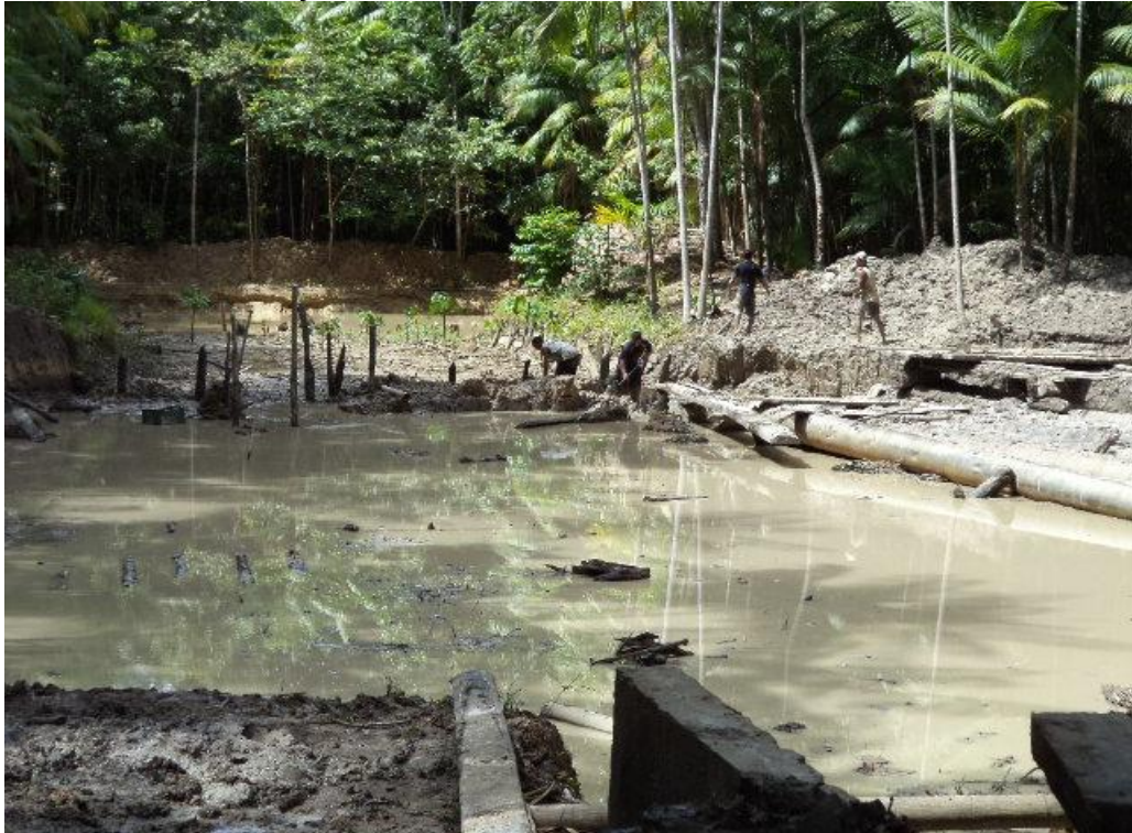
Foto 11 – Construção de tanque de piscicultura na comunidade Boa Esperança.
