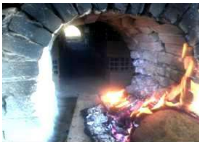
Figura 1: Forno caieira em São Miguel do Guamá (PA).
