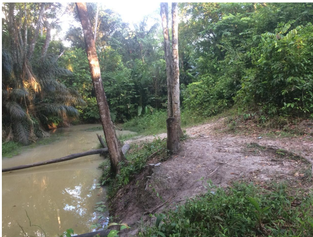
Figura 8. Trecho do Igarapé da Rocinha com erosão, 2019
