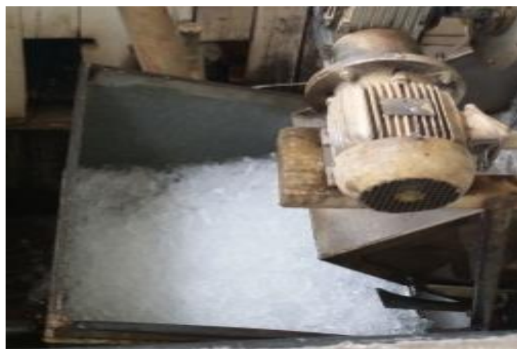
Figura 3.6 - Depósito e bomba de gelo no frigorífico.
