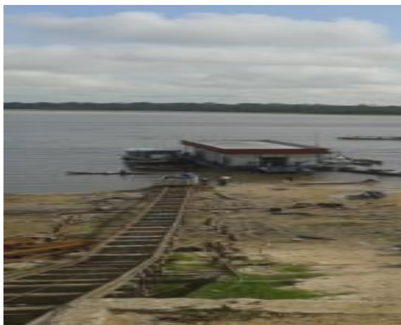
Figura 3.4 - Trilhos e cabo de aço para tração do carro.
