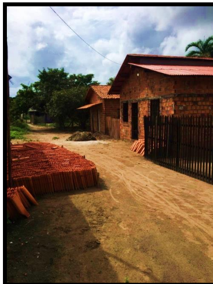
Figura 4. Casas em alvenaria em Vila Verde
