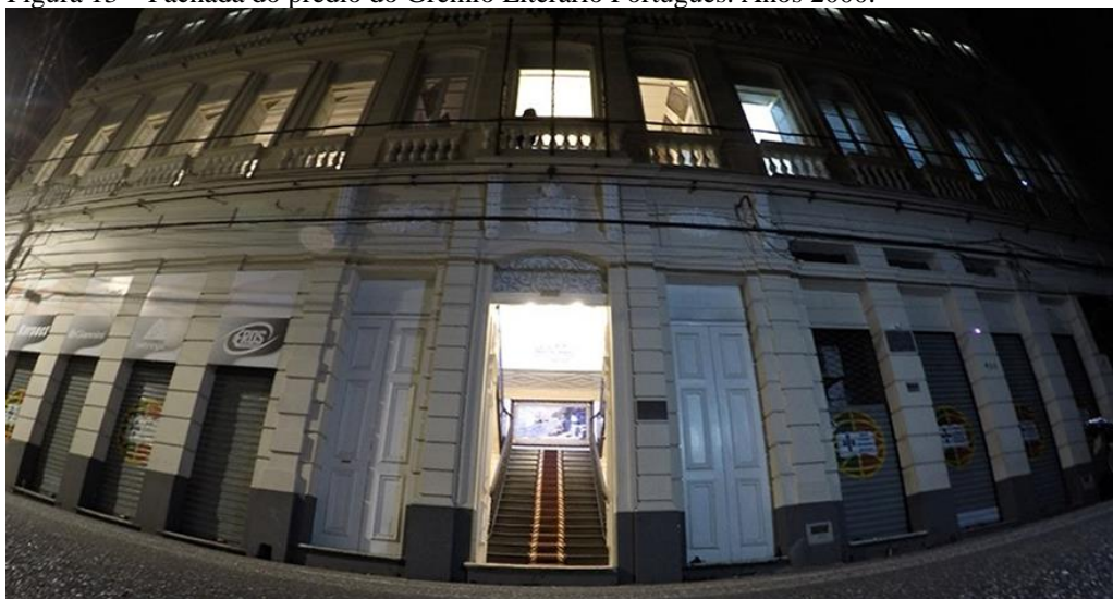
Figura 13 – Fachada do prédio do Grêmio Literário Português. Anos 2000.
