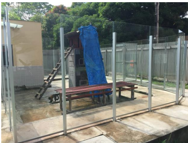
Figura 3. Viveiro recinto (vista parcial). Composto por duas áreas, de 45,09 m 2 cada, cercadas com painéis de vidro temperado, liso, incolor, espessura de 10 mm, estruturado com perfis de alumínio. Piso cimentado, cor natural, com conjuntos de dilatação plásticos, com espaçamento de 1m.
