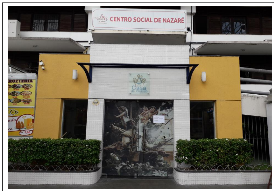
Figura 7 – Fachada da Casa de Plácido.
