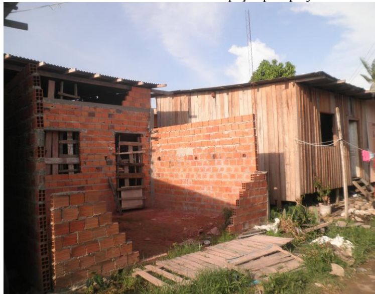
Figura 8: Casa sendo construída em área de desocupação pelo projeto PAC Riacho Doce.
