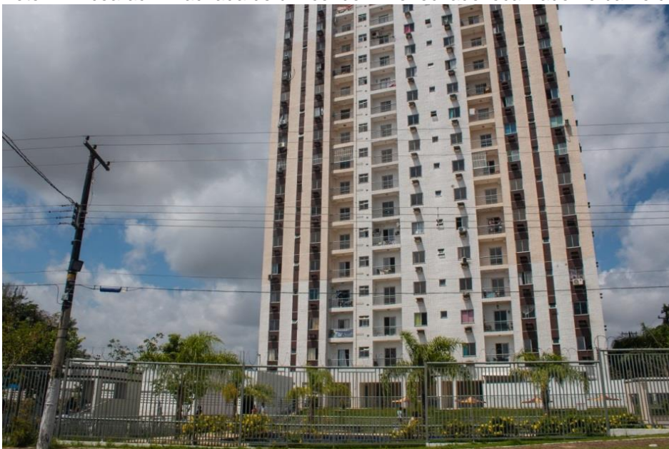
Foto 14 - Icoaraci – Fachada de um condomínio fechado localizado no bairro do Cruzeiro. 2019.
