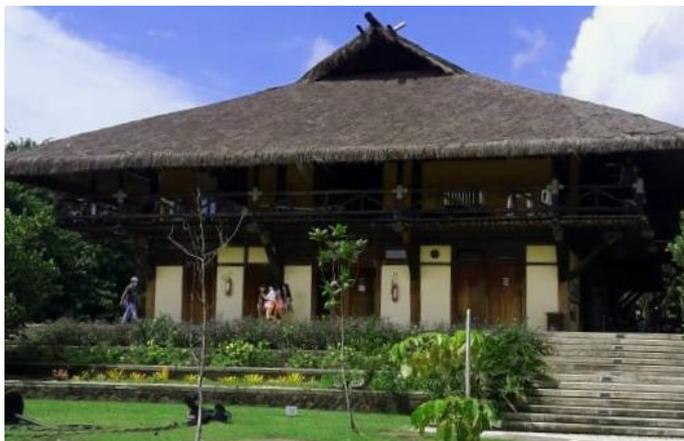
Figura 36: Edificação que no Mangal das Garças abriga o Memorial Amazônico da Navegação (pav. inferior) e o Restaurante Manjar das Garças (pav. superior). A estrutura do prédio é em angelim e a cobertura em fibra de piaçava. Fonte: Sidney Costa Filho, 2021.
