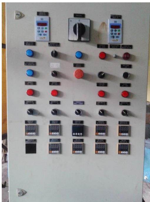
Figura 26: Painel de controle da planta piloto de craqueamento.
