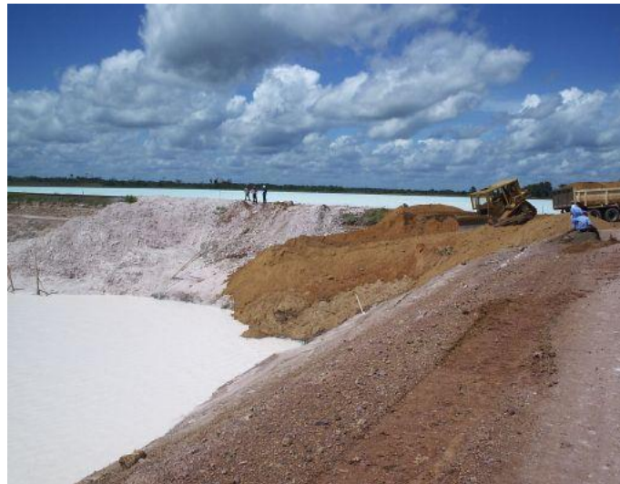
Figura 5. Início do acondicionamento de uma das áreas de exploração de caulim na Imerys Rio Capim Caulim (IRCC) para posterior reflorestamento (Fonte: Adaptado de ROCHA JUNIOR, 2015)
