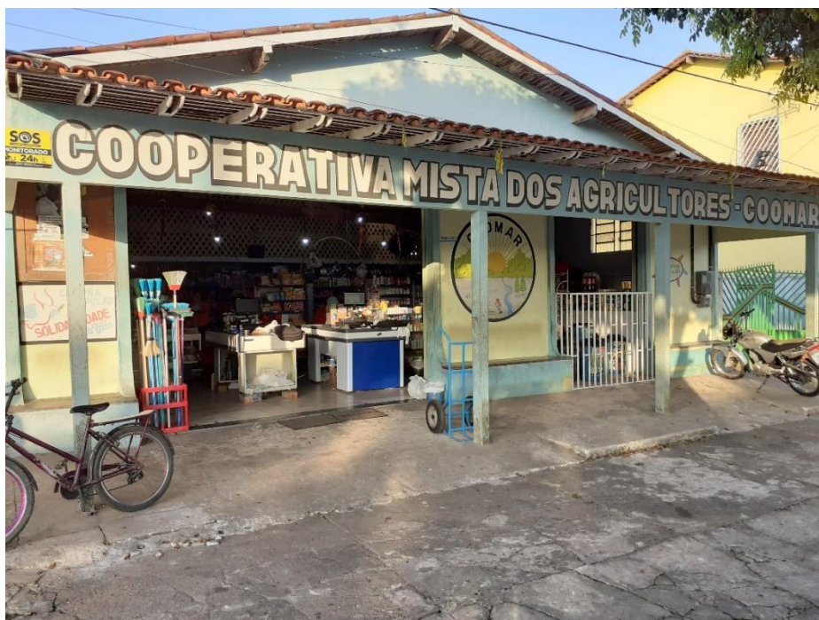
FOTOGRAFIA 04 – Cantina Solidária, onde também funciona a sede da Coomar.
