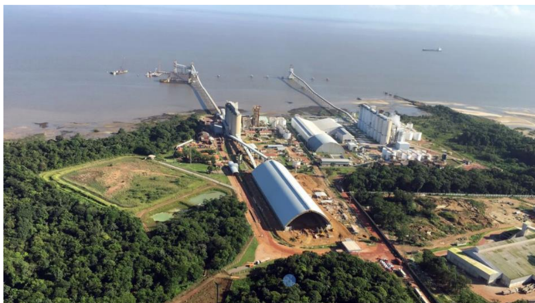
Figura 7 – Terminal de Grãos Ponta de Montanha – TGPM.
