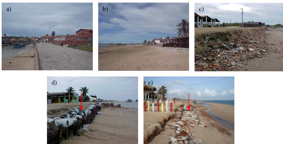
Figura 6. Inundação da maré de sizígia (março) e efeito da erosão na vila de Torrões (a) e (b); recuo da linha de costa na praia da Barreira (c); destruição da obra de contenção na em ponto na praia da Barreira (2007) nos meses de março (d), e novembro (e).
