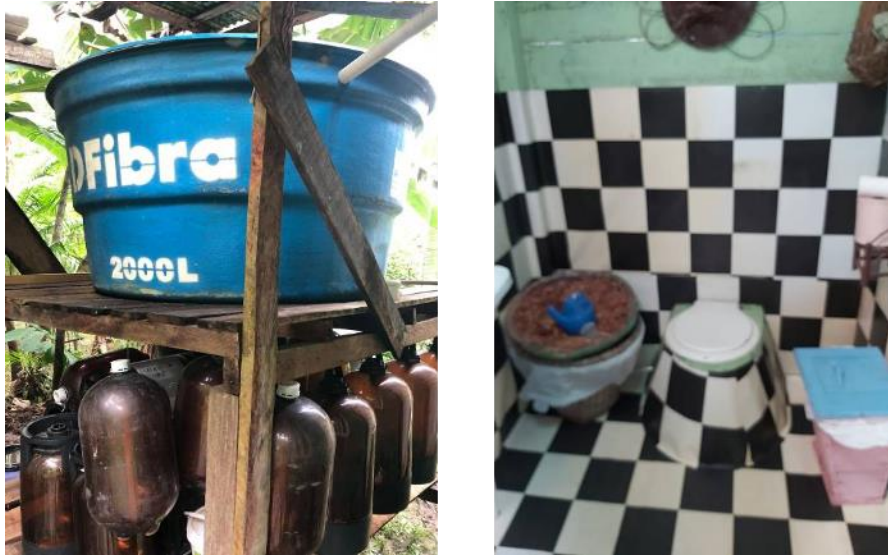
Fotografia 4 – Sistema de aproveitamento da água da chuva e banho ecológico
