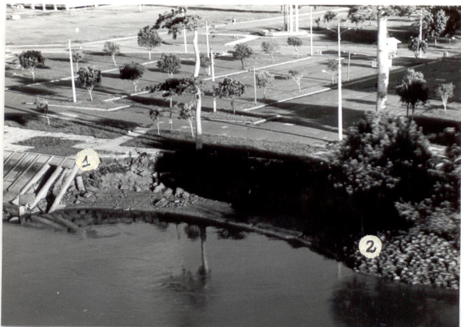
FIG. 27a: Vista frontal da figura anterior. Em ① limite entre a construção antiga e atual, ② enrocamento provisório utilizado na tentativa de conter a erosão.
