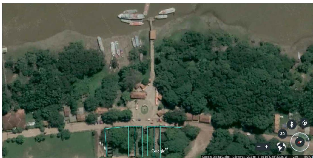
Figura 57: As linhas em azul mostram o “tortinho” presente na fachada e as paredes retas e tortas que existem no educandário 44 . Imagem obtida pelo Google Earth em 08/01/2019 às 22:35.
