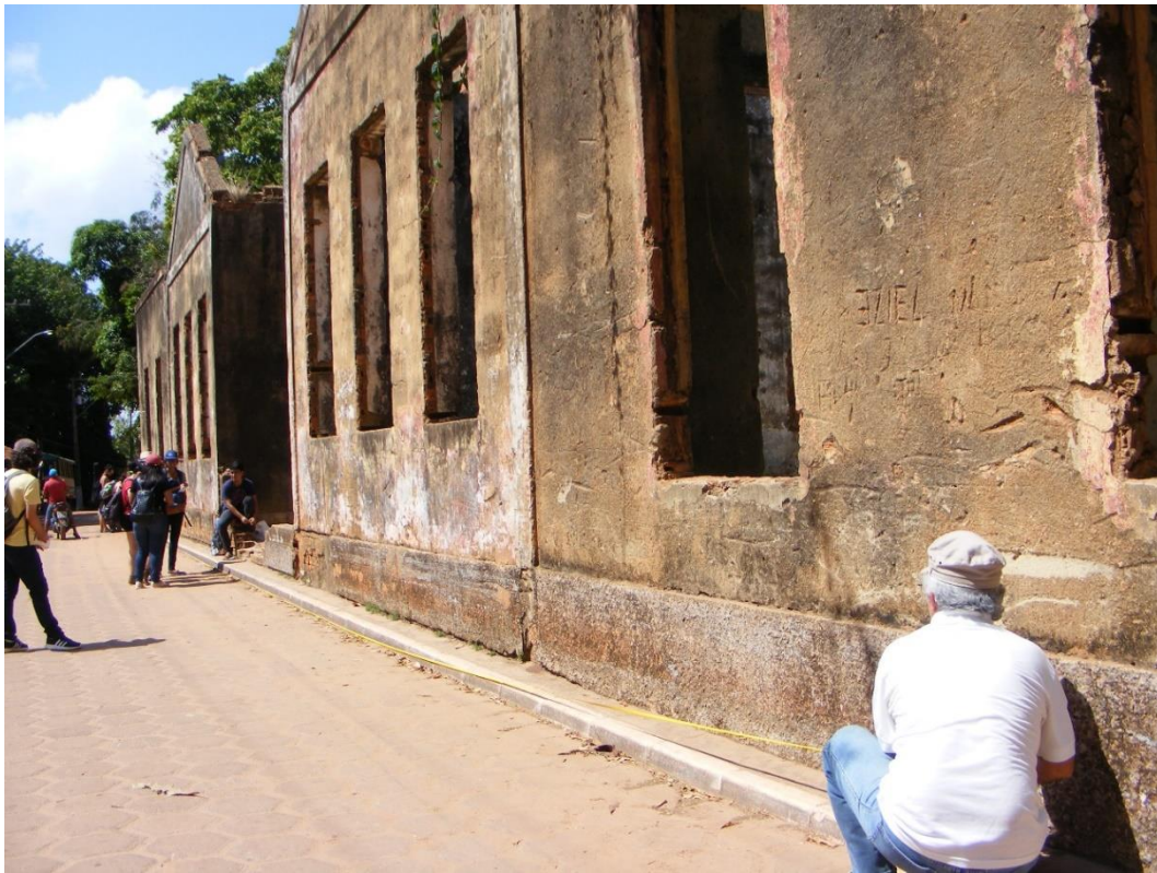
Figura 41: Dr. Fernando Marques fazendo a medição da fachada. Foto: Mailane Sampaio
