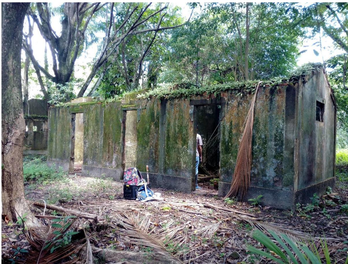
Figura 29: Fachadas do prédio B 21 . Foto: Laura Fontal
