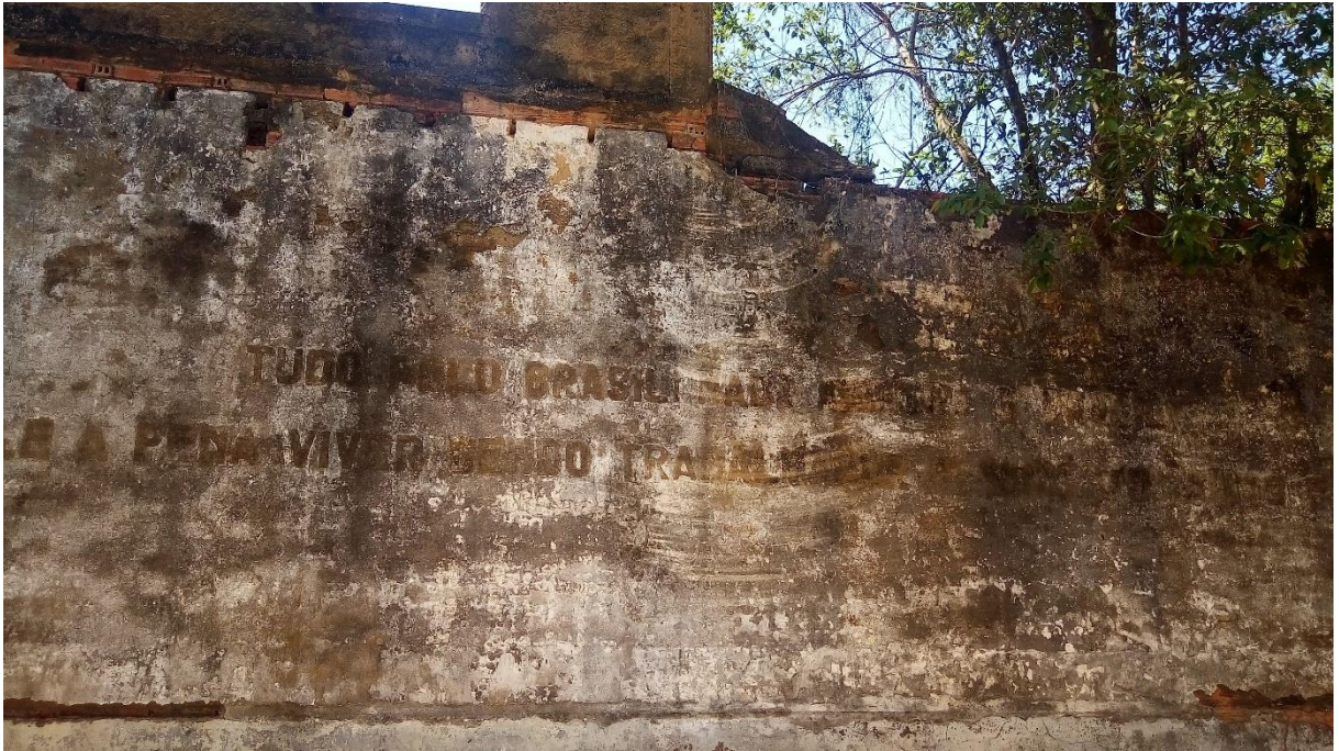
Figura 15: Frases na parede do cômodo 7 no prédio principal. Foto: Thalia Pereira
