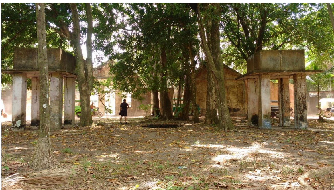
Figura 35: Caixas d'águas 1 e 2; poço. Foto: Amanda Seabra
