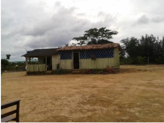
Foto 2 – Escola antes da reforma.
