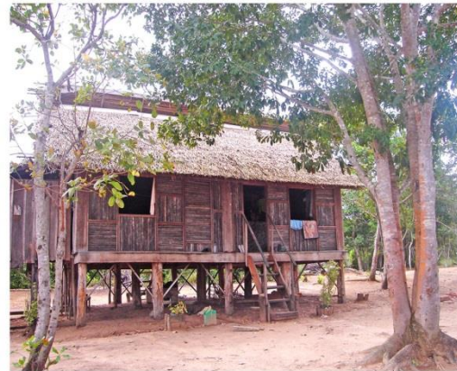
D - Aspecto da casa de madeira na comunidade de Lucas
