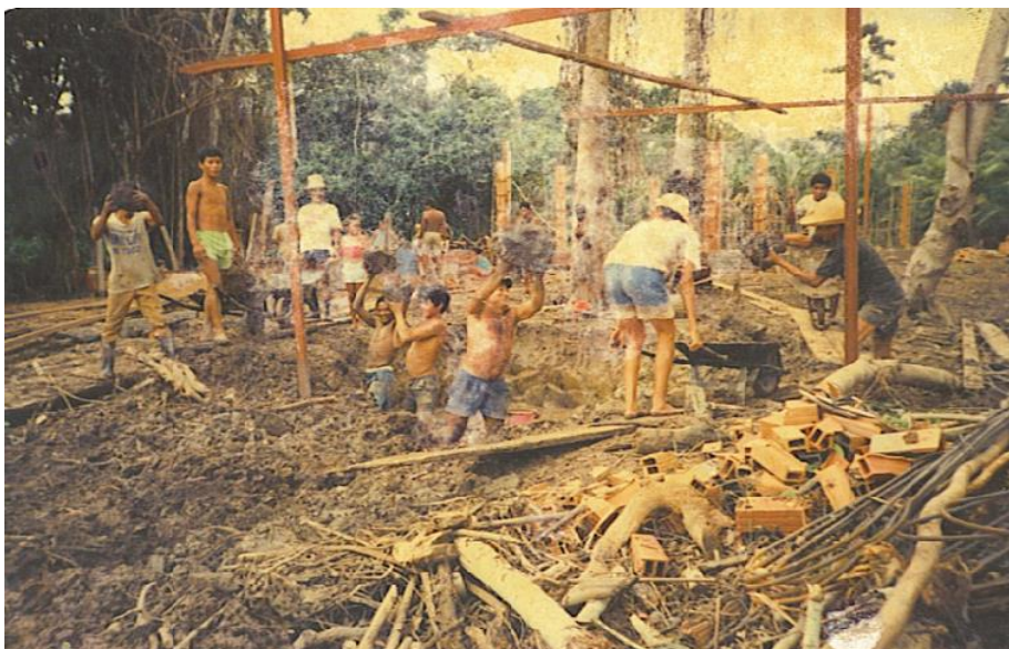
Figura 8: Construção da sede da Associação Mutirão
