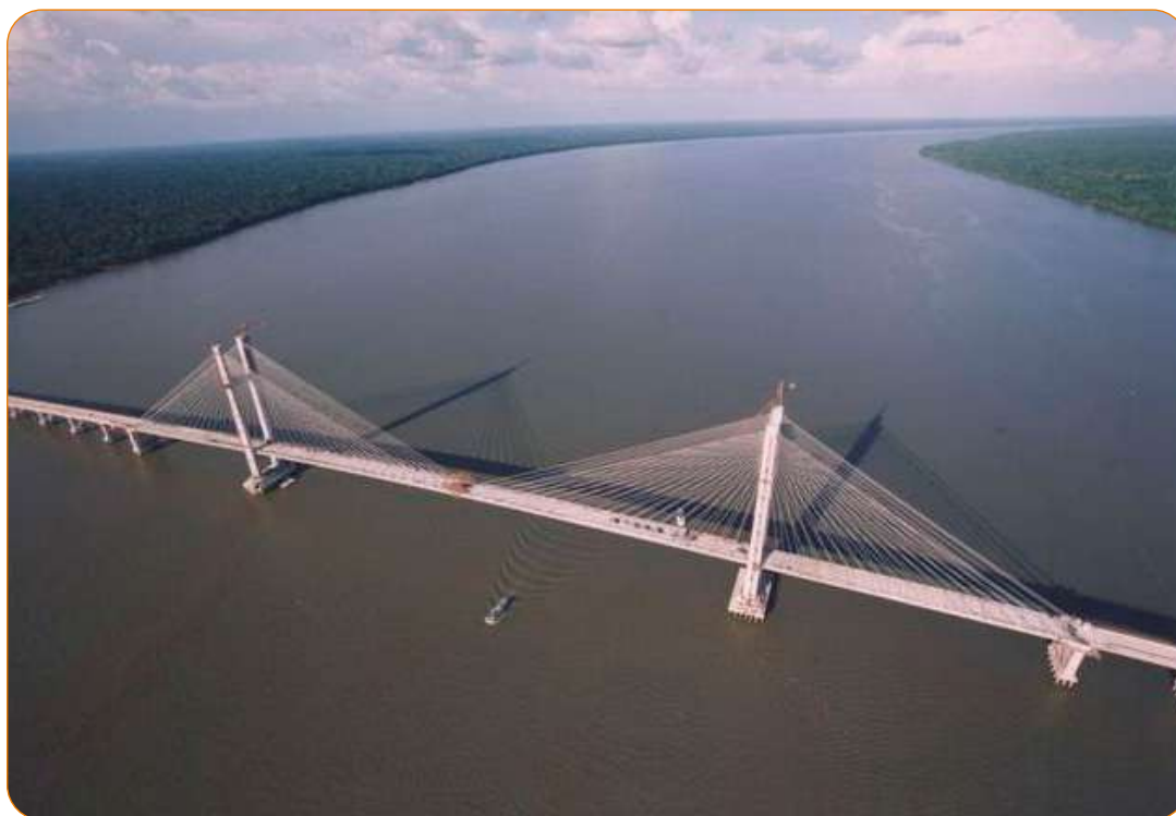
Figura 34 – Alça Viária. Ponte sobre o rio Guamá
