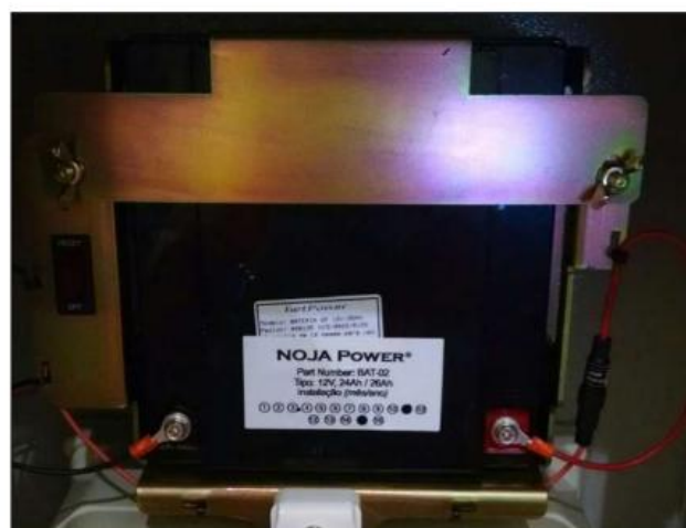
Figura 2.10 - Bateria selada 12 VCC 24-26Ah. Fonte: NOJA POWER (2017).
