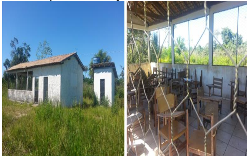
Figura 22- Primeiras instalações construídas para o trabalho do GTAE.
