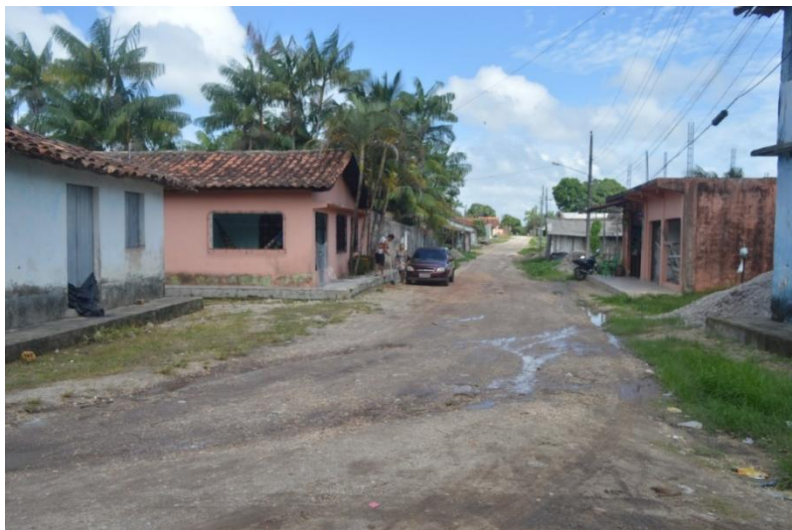
Figura 11: Rua da Vila do Treme indo em direção ao Porto Principal
