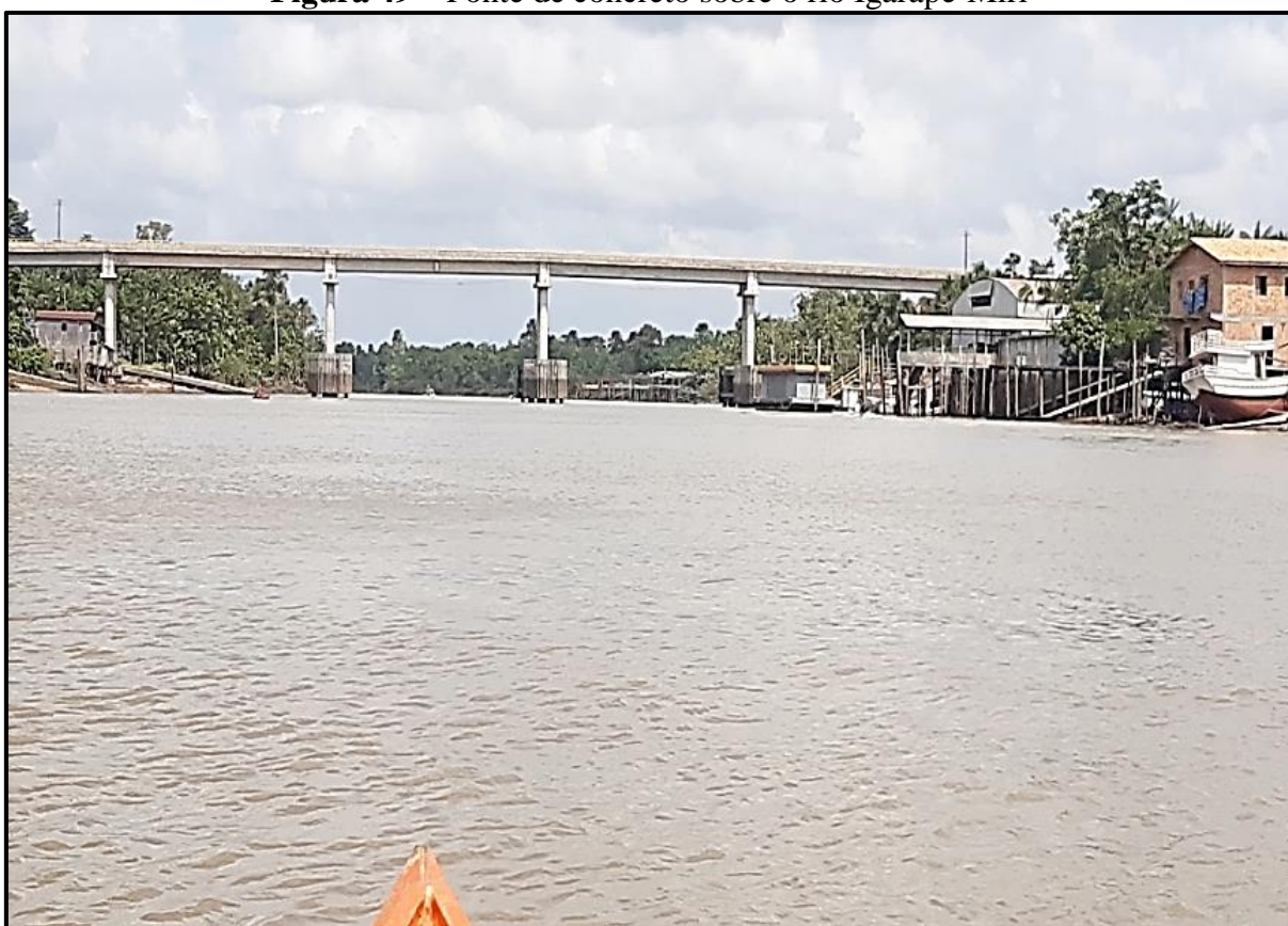
Figura 49 – Ponte de concreto sobre o rio Igarapé-Miri
