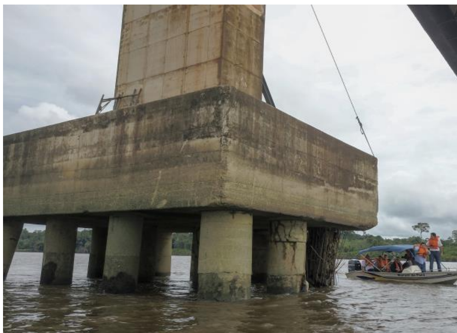
Figura 2.9 - Bloco sobre estacas em pontes. Fonte: OLIVEIRA, 2019.
