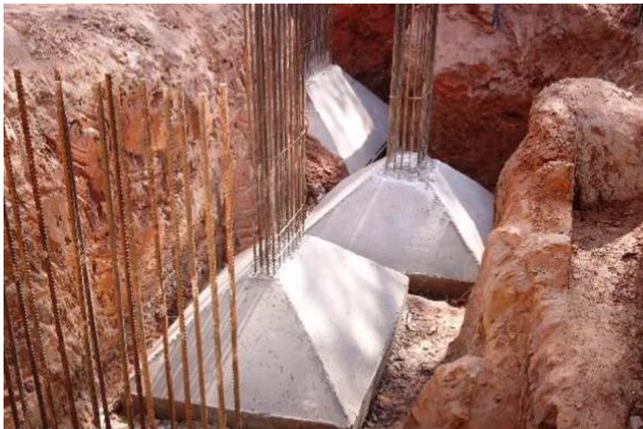
Figura 2.8 - Fundação rasa (Sapata) em obra. Fonte: TOCA OBRAS, 2020.
