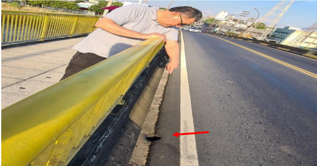
Figura 4.11 - Vista de um ponto de drenagem na ponte Senador Fábio Lucena.
