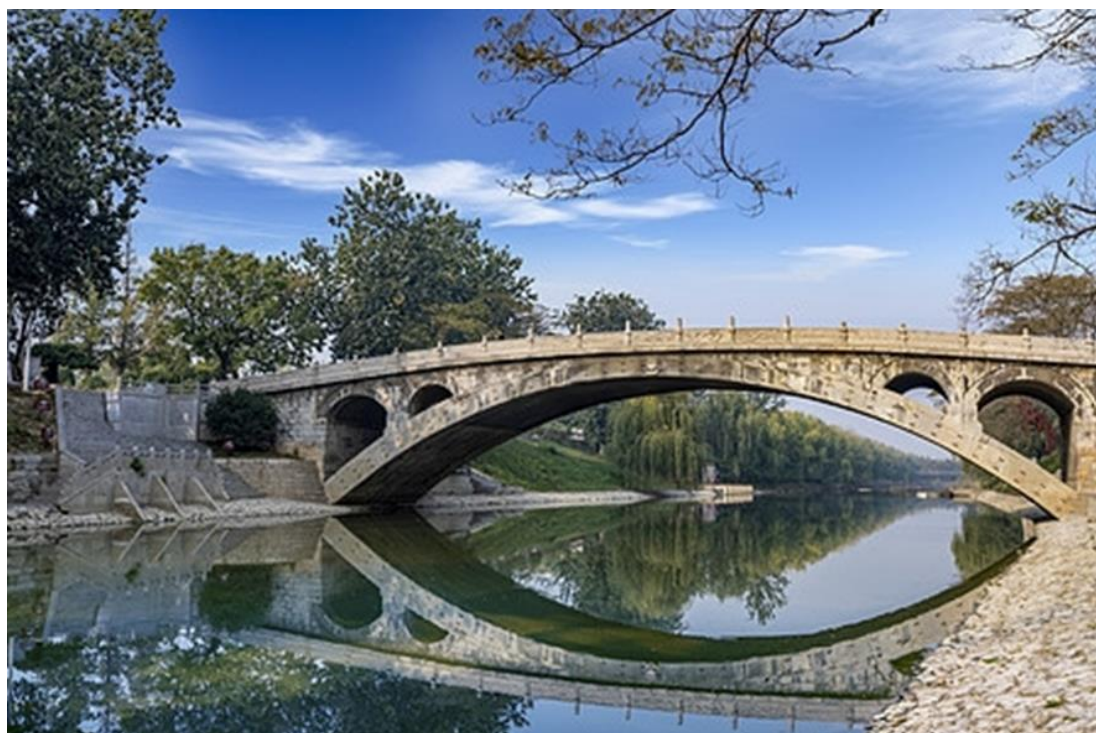
Figura 2.5 - Ponte Zhaozhou (China).
