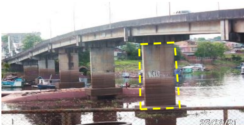
Figura 4.5 - Vista da ponte em estudo, com destaque ao “ pilar de concreto”.
