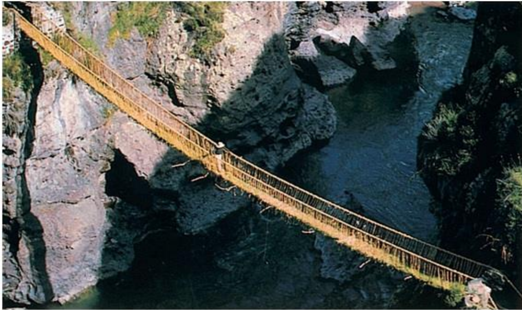
Figura 2.1 - Ponte suspensa primitiva sobre uma ravina no Peru, feita de cordas de fibras vegetais trançadas.
