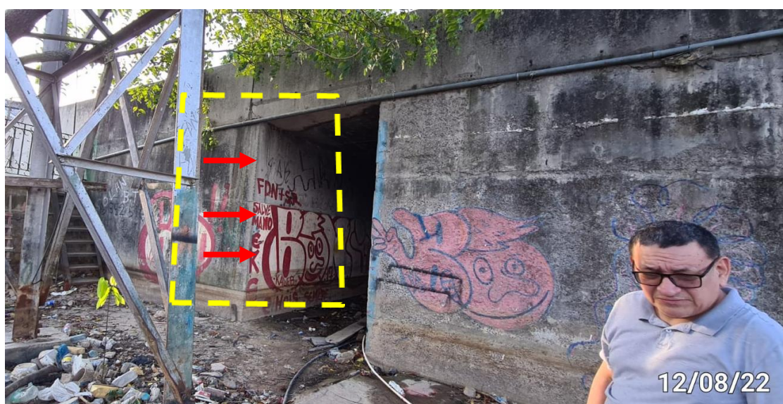
Figura 4.4 - Vista do encontro na cabeceira da ponte pelo bairro São Raimundo.
