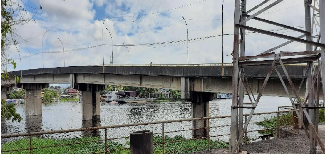
Figura 4.1 - Vista lateral esquerda da ponte em estudo, sentido centro-bairro.
