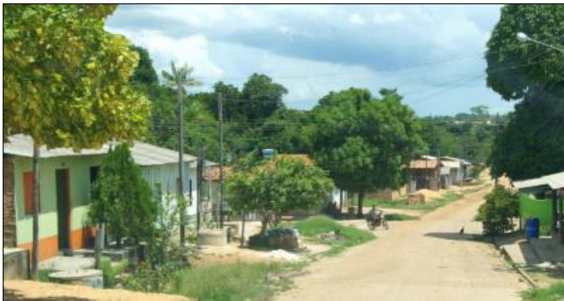
Figura 40 - Rua sem pavimentação nem calçada (Bairro Centro - 2011).
