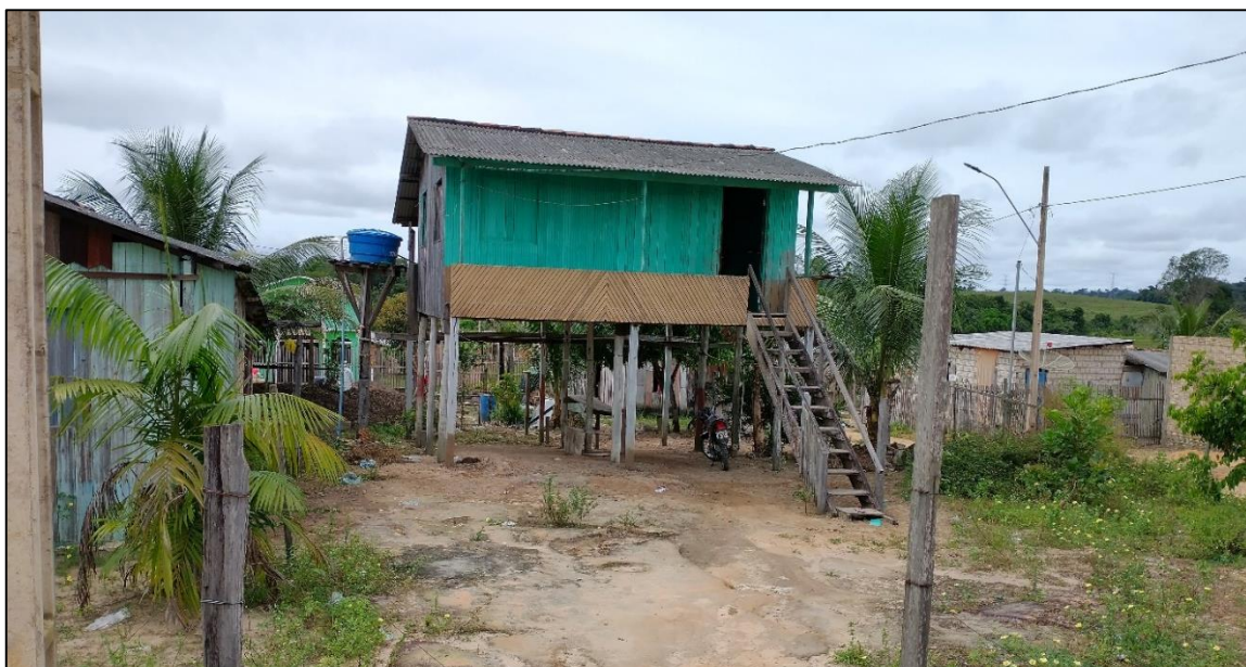
Figura 45 - Residência com estrutura de palafita no bairro Nova Conquista. Foto: Genilson Santana Cornélio (Maio de 2021).
