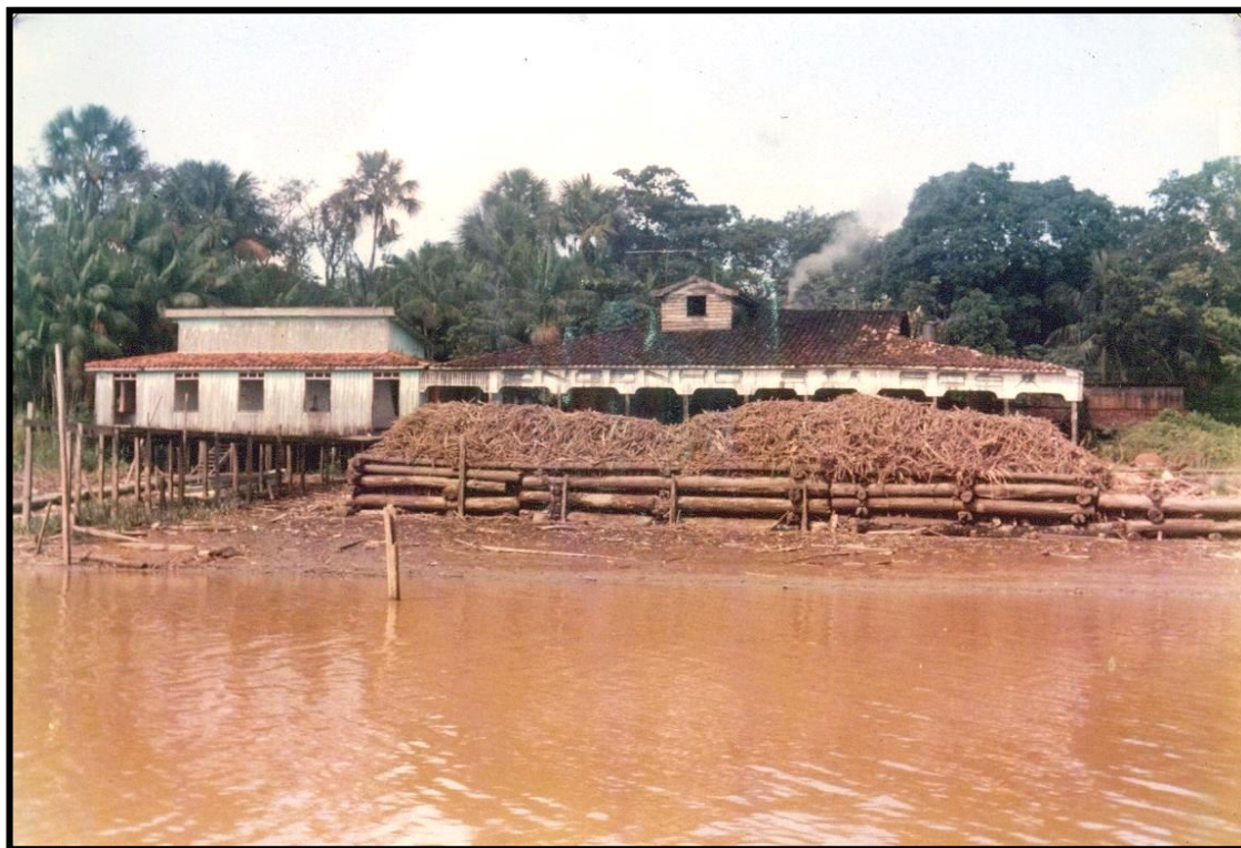
Figura 9. Fotografia do Engenho Santa Rosa, rio Guajarazinho, ilhas de Abaetetuba-PA (data aprox. 1970).
