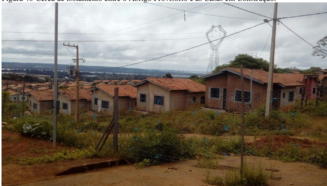
Figura 40-Cerca de isolamento entre o Abrigo Provisório e as Casas em Construção.
