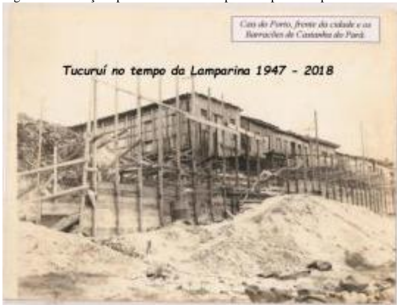
Figura 5-construções próximas ao cais do porto responsável por receber a coleta da castanha
