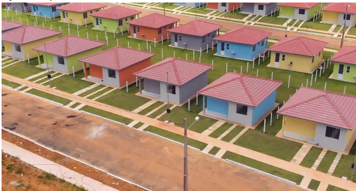
Figura 37- conjunto residencial Viva Cidade.
