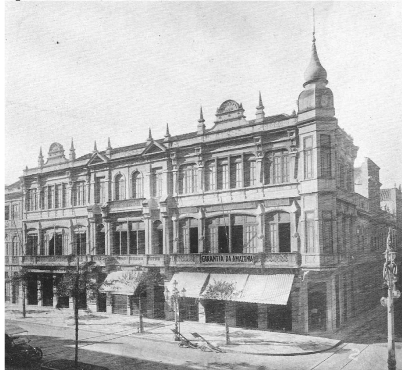
Figura 15 – Garantia da Amazônia – Edifício na avenida Rio Branco.
