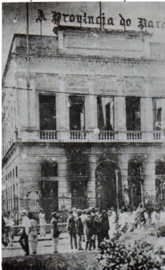
Imagem 19: Sede do jornal A Província do Pará depois do incêndio.
