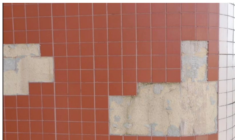
Figura 20: Exemplo de deslocamento cerâmico
