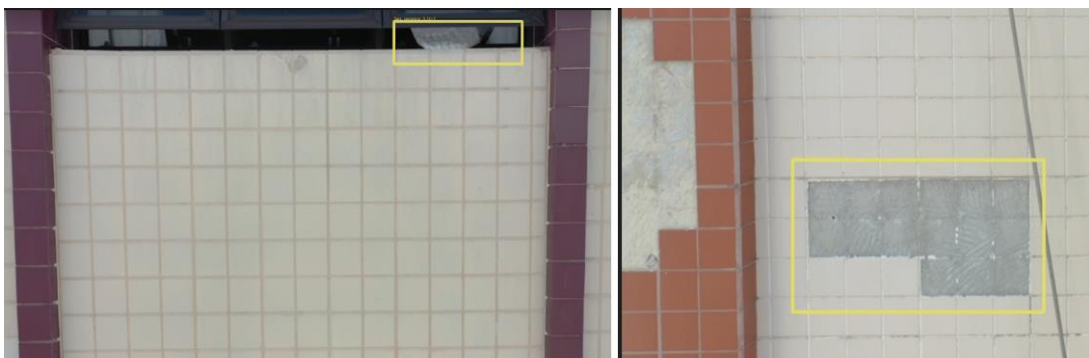
Figura 33: Imagens resultantes do treinamento: a) falso positivo e b) falso negativo
