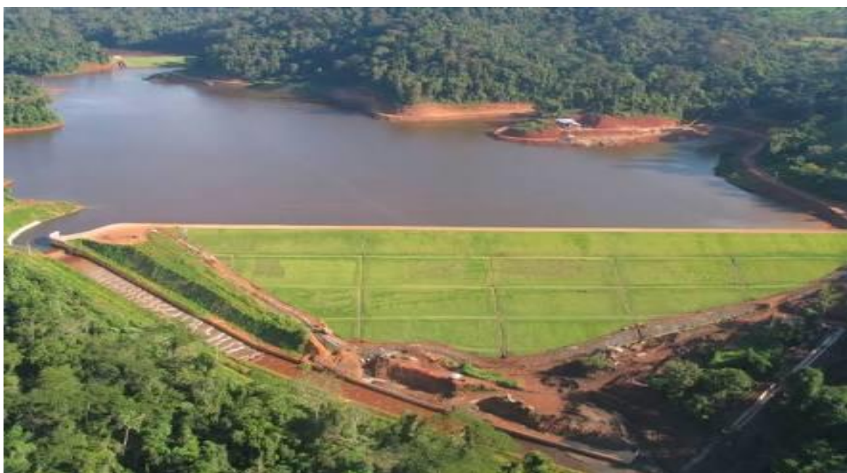
Fotografia 3- - Barragem da Área de Proteção Ambiental (APA) do Igarapé do Gelado
