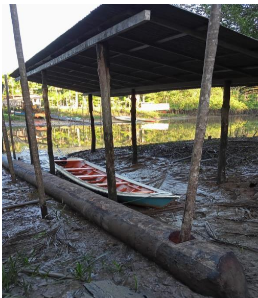
Foto 16 Porto de residência com ponte convencional auxiliada por porto de miritizeiro Fonte: acervo do autor.
