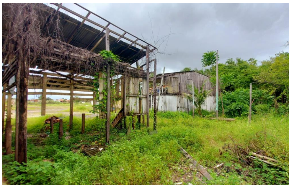
Figura 46- Casa II abandonada no estacionamento.
