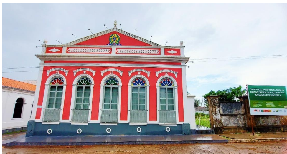
Figura 12– Fachada do Paço Municipal Monsenhor Edmundo Igreja, após revitalização.
