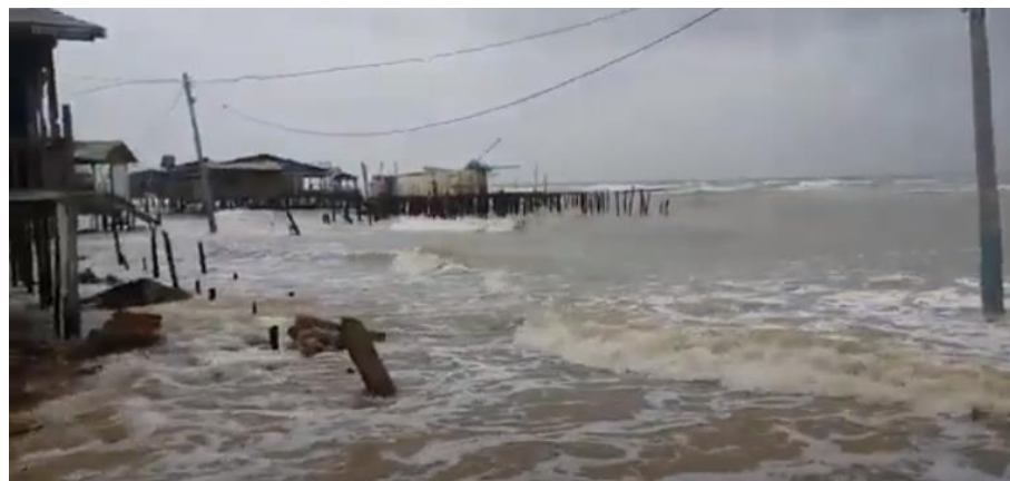
Figuras 4 e 5 – Imagens de casas destruídas pelo fenômeno das marés altas na praia do Crispim-PA. Em 28 de março de 2019.
