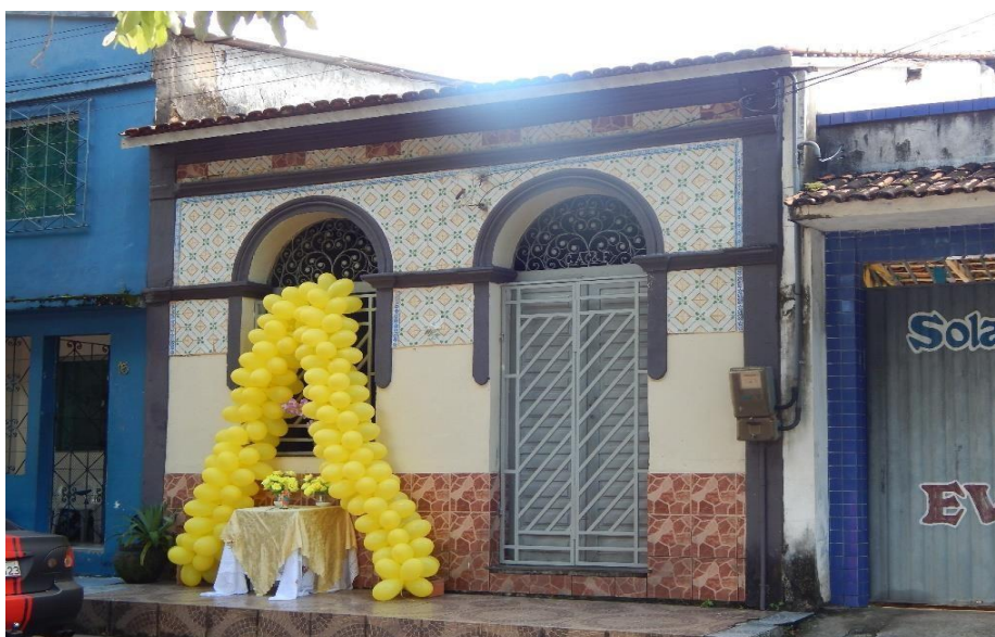
Figuras 8 e 9– Construção antiga de Marapanim localizada próximo ao Paço Municipal Monsenhor Edmundo Igreja.
