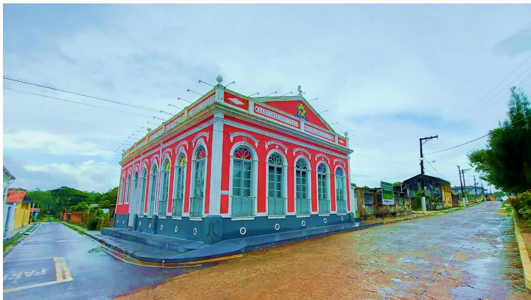
Figura 13– Prédio histórico – Paço Municipal após revitalização
