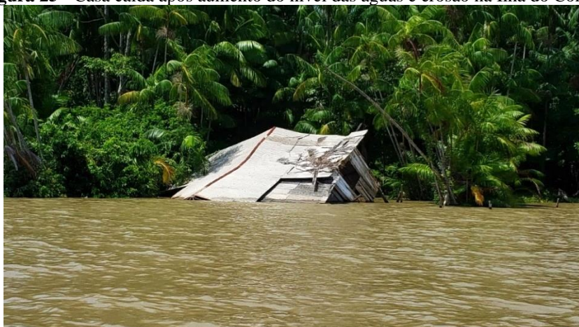
Figura 25 - Casa caída após aumento do nível das águas e erosão na Ilha do Combu
