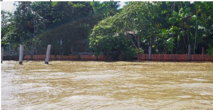
Figura 24 - Barreira para evitar a força da água e a erosão no restaurante Casa Combu
