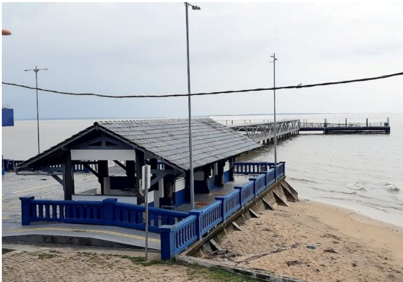
Figura 29 – Mosqueiro: antigo Trapiche de Mosqueiro pós-reforma
