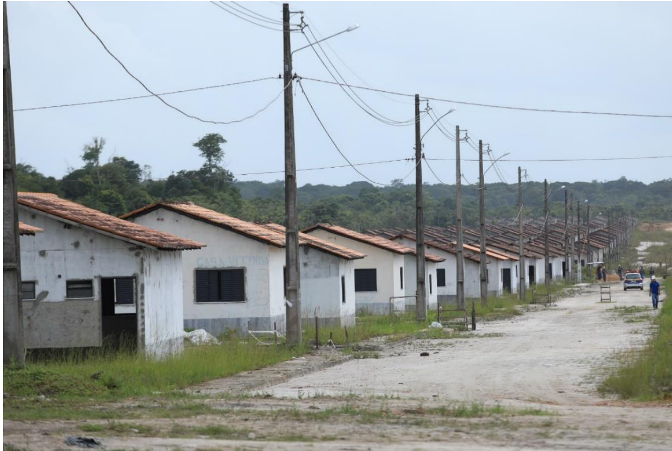
Figura 21 – Bairro Carananduba: obras do Residencial Popular Viver Mosqueiro
