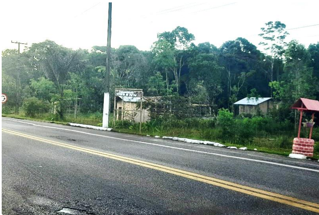
Figura 20 – Mosqueiro: ocupação “Vitória do Portal”, às margens da rodovia PA-391
