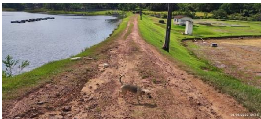
Figura 20– Crista da Barragem Igarapé Sete Voltas/PA
