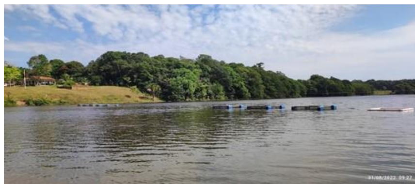
Figura 22 – Reservatório da Barragem Igarapé Sete Voltas/PA
