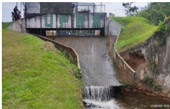
Figura 21– Vertedouro da Barragem Igarapé Sete Voltas/PA
