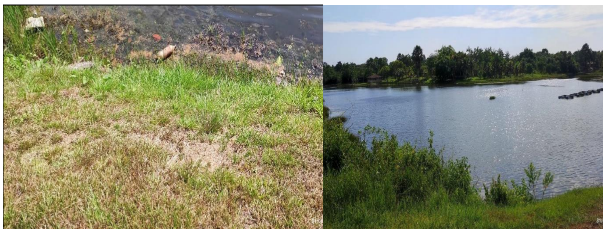
Figura 18– Talude montante – Barragem Igarapé Sete Voltas/PA
