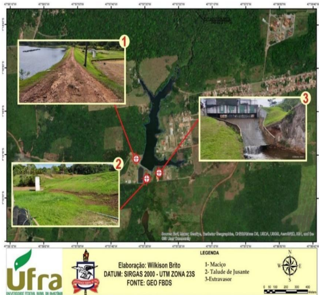
Figura 5 -Elementos constitutivos da barragem do Igarapé Sete Voltas
