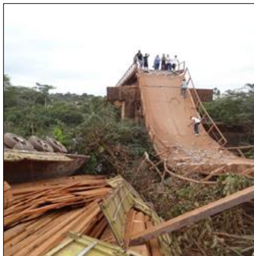
Figura 1.3 - Ponte sobre o o rio Arataú 1º colapso
