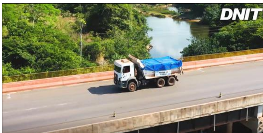
Figura 1.1 - Prova de carga sobre a ponte Poraquê
