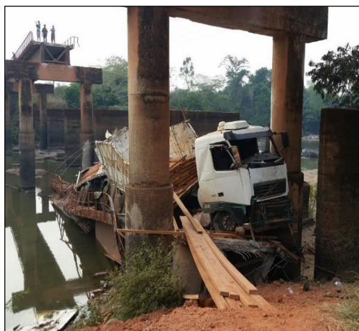
Figura 1.4 - Ponte sobre o rio Arataú 2º colapso
