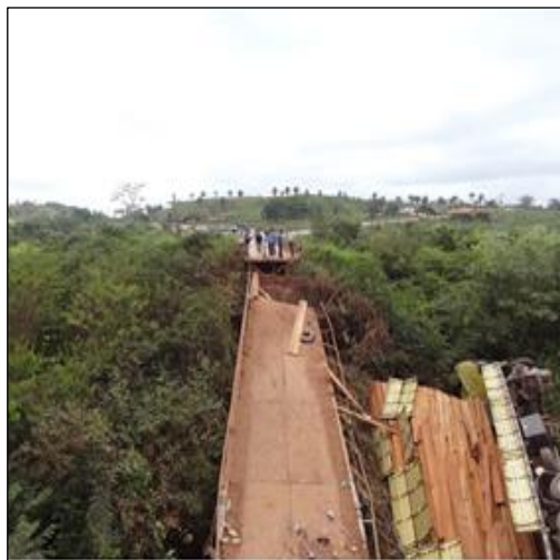
Figura 1.3 - Ponte sobre o o rio Arataú 1º colapso
