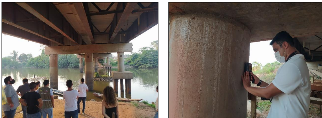
Figura 4.1 - Inspeção Visual e Avaliação da ponte Anapú
