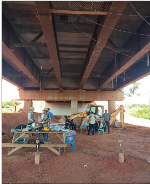
Figura 2.11 - LVDTs instalados na ponte sobre o rio Arataú
