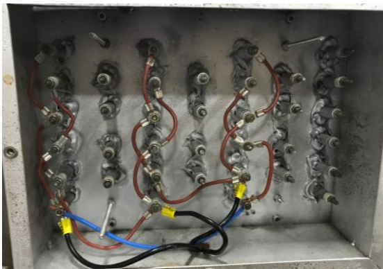
Figura 3.33 - Ligação delta de 9 resistências (8,0kW)
