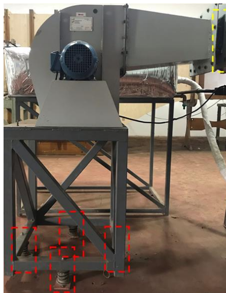
Figura 3.29 - Instalação do ventilador.
