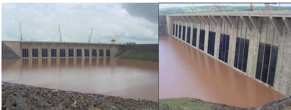
Figura 3.6 - Visão geral da tomada d'água das unidades geradoras da casa de força 2. Fonte: Acervo Eletrobrás Eletronorte (2000)
