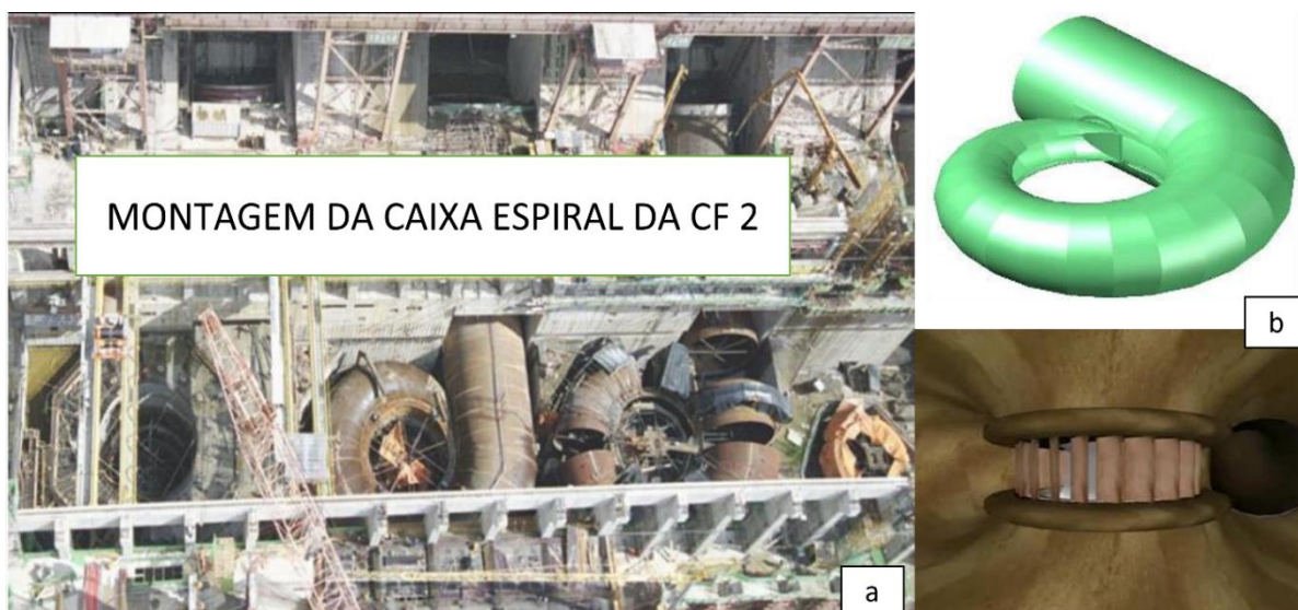
Figura 3.8 - a) Caixa espiral durante a montagem da casa de força 2 da UHE Tucuruí; b) Representação externa e interna, da caixa espiral de uma unidade geradora. Fonte: Acervo Eletrobrás Eletronorte (2000)
