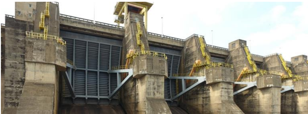
Fig. 12 Pilar e viga-munhão.
