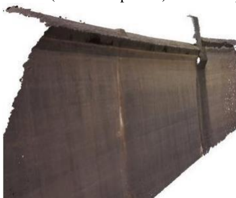
Figura 08 – Modelo 3D (nuvem de pontos) de uma seção do vertedouro
