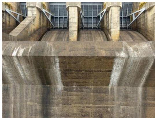
Fig.14 Carbonatação.
