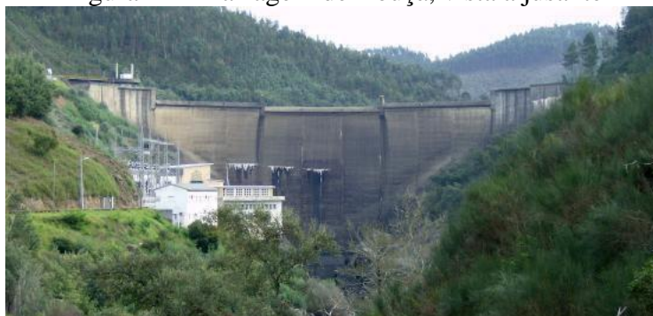
Figura 11 – Barragem de Bouçã, vista a jusante
