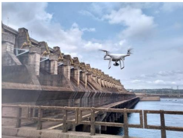
Fig. 3 VANT iniciando as fotos no Vertedouro da UHE Tucuruí.
