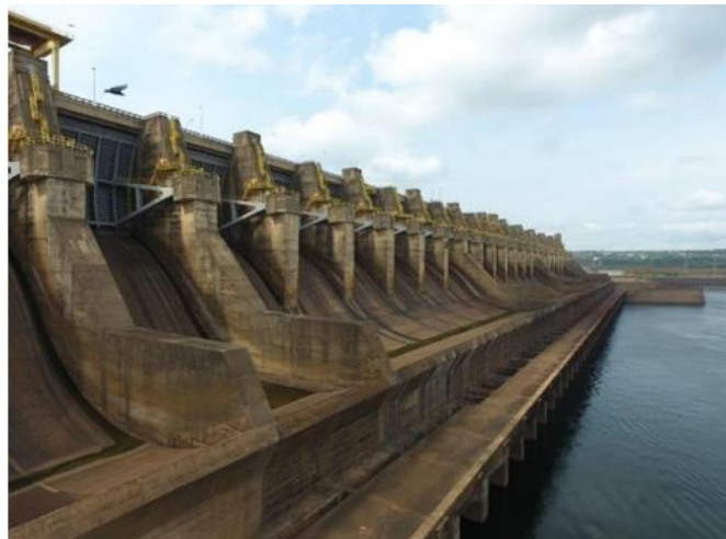
Fig. 6 Vertedouro UHE Tucuruí
