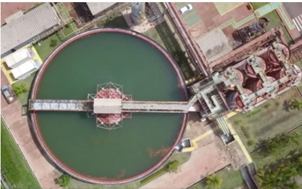
Figura 4 - Clarificador da ETEI, localizado em Barcarena-Pa.
