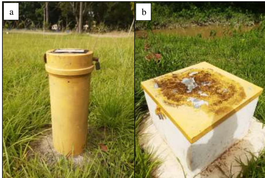
Figura 11 – Infraestrutura dos poços de monitoramento: a) PM-07 e b) PM-06
