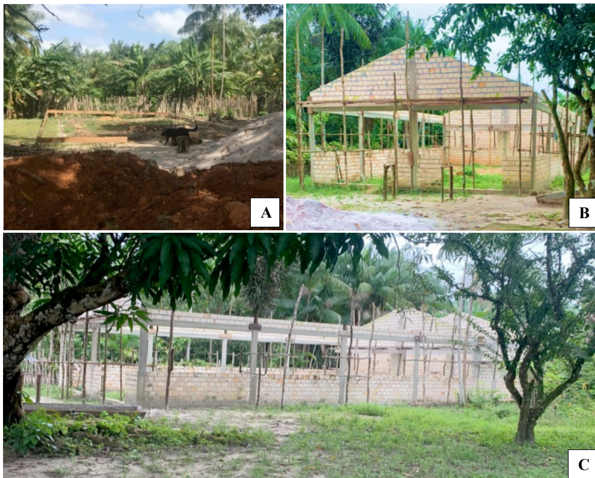
Figura 5 - Construção do barracão sede da Associação Quilombola Vida Para Sempre Jacarequara (AVPS), comunidade quilombola do Jacarequara, Santa Luzia do Pará, Pará. A – Início da construção em 2021, B e C: Progresso da construção em 2022.
